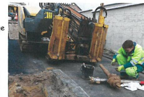
Le retour de la tête de forage s'effectue avec un trépan de taille supérieur qui tire en même temps les fourreaux préalablement soudés ensemble.
